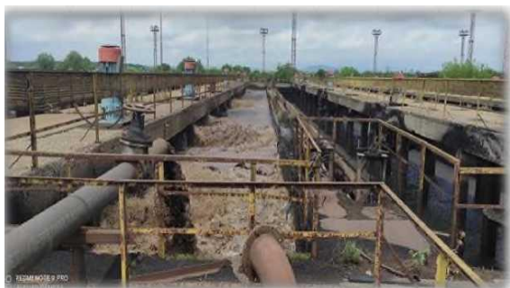
Съществуващо положение – биобасейн с повърхностна турбинна аерация
